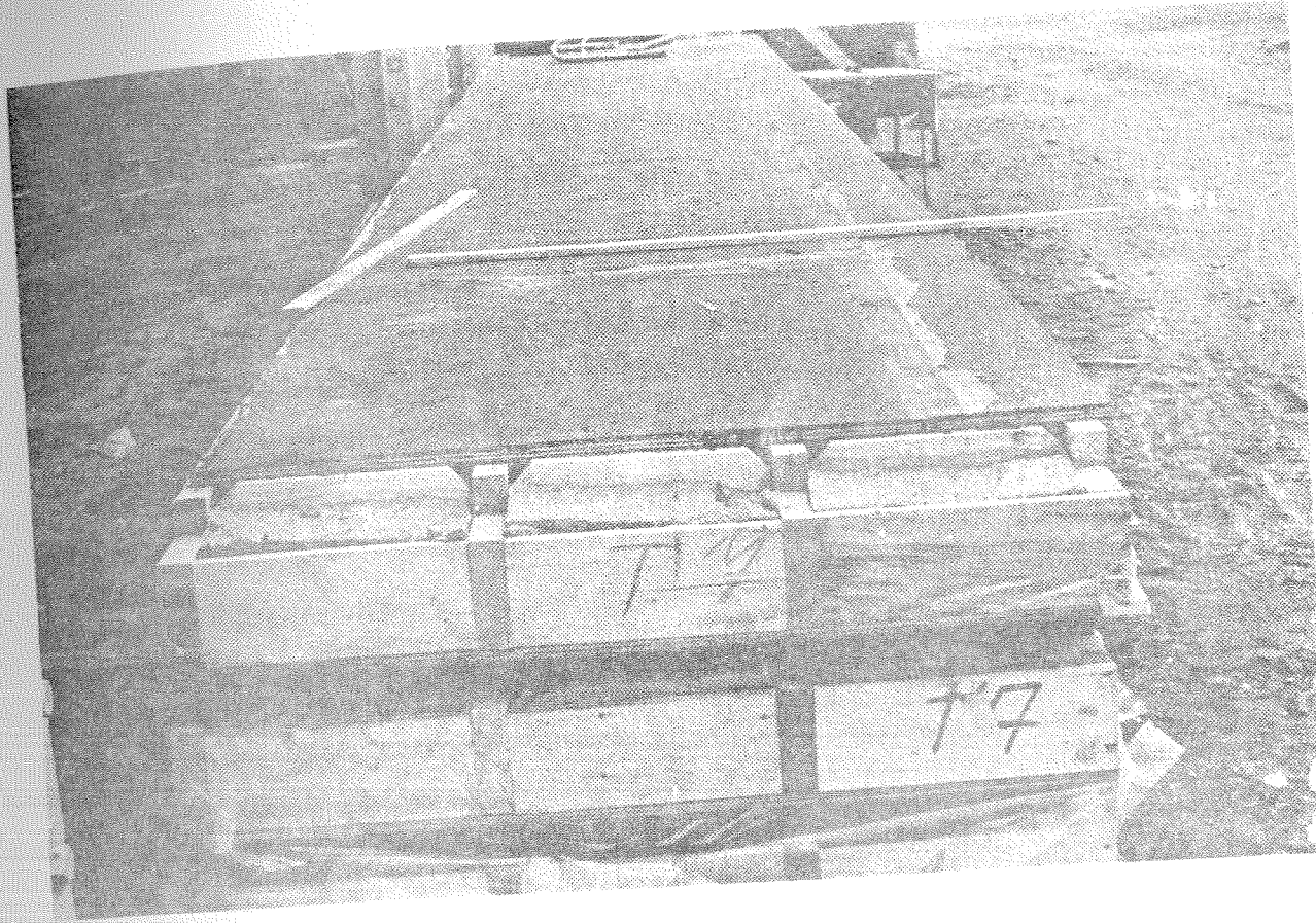
Fig. 21. Tagelementer inden oplægning.
